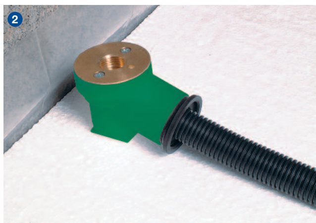
Afb. 5.15 Aansluiten met de aansluitfitting op de vloer.
