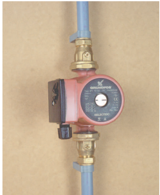
Afb. 6.3 Aansluiting op een pomp.
