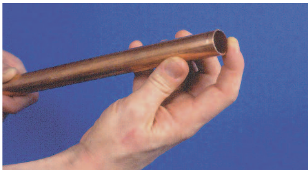
2. Controleer of zich aan de uiteinden geen bramen of slijpsel bevindt.
