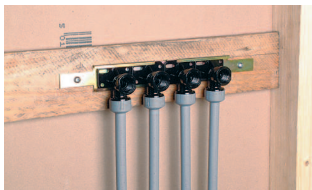
Afb. 5.17 Aansluiting van vier muurplaatkoppelingen met montageplaat.
